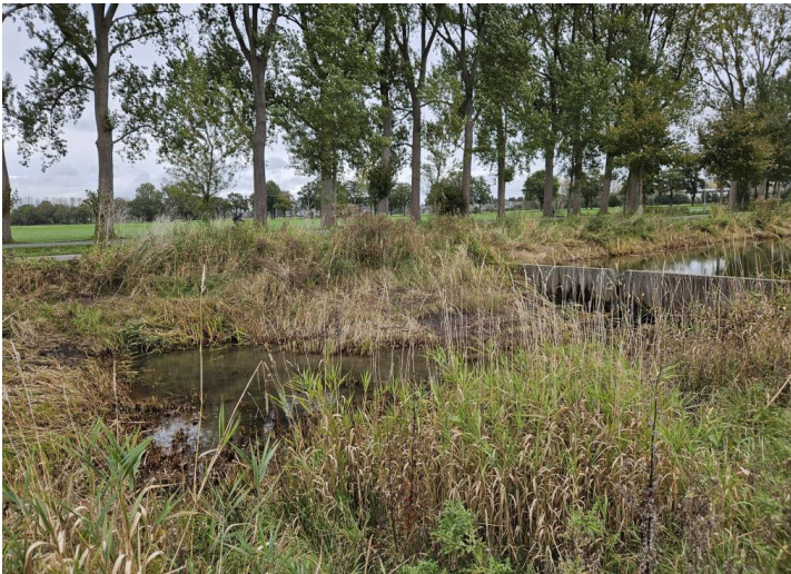
Figuur 11: Slechte connectiviteit van duikers. A. Verbinding tussen het Nieuwe Kanaal en de Ossenkampen, zonder zichtbare duiker. B. Slecht verbonden duiker aan de Slagsteegsloot. Doordat de duiker ver boven het waterpeil ligt is hij voor veel vissoorten onbereikbaar.
